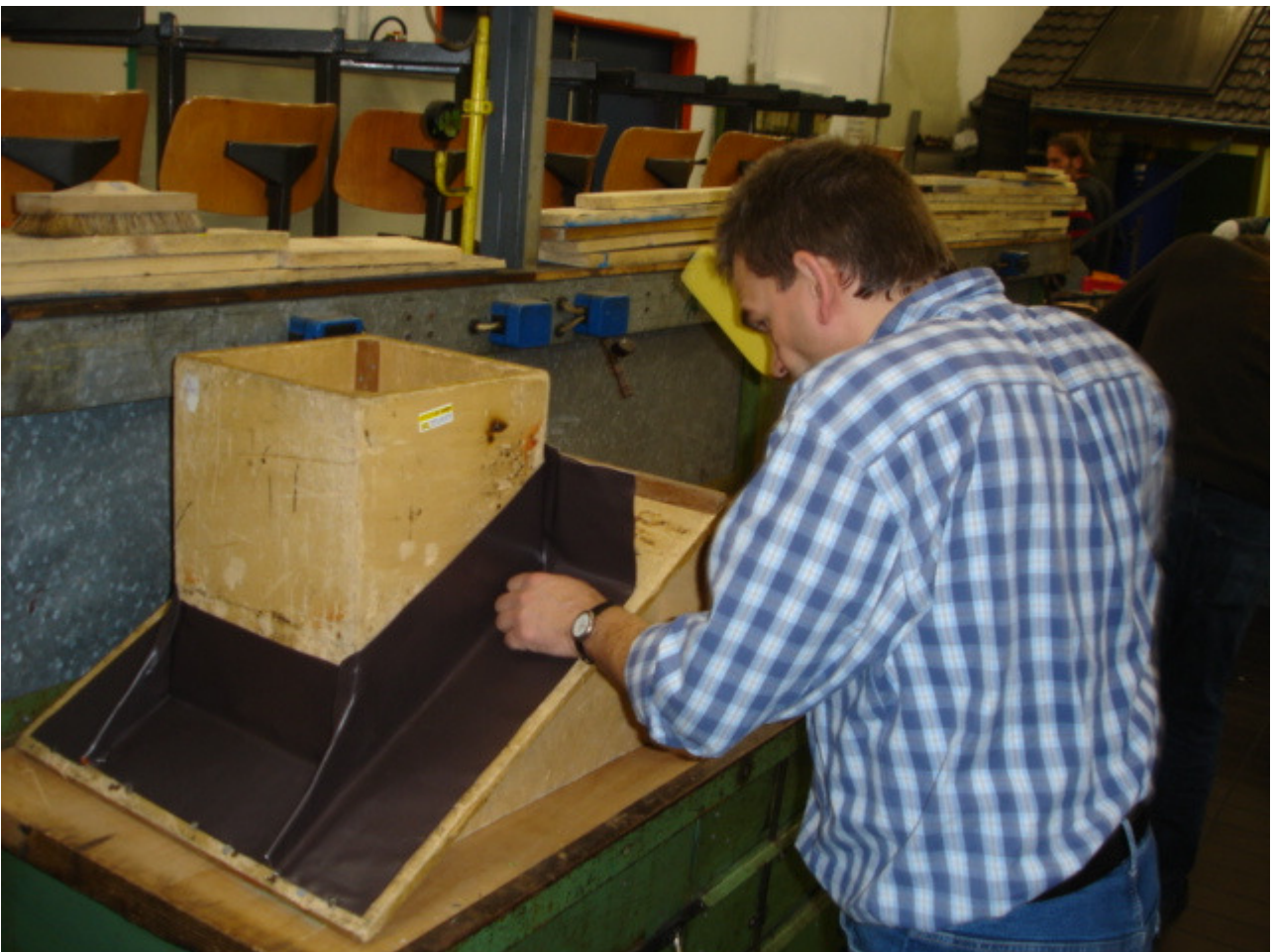
Detailausbildungen eines Kaminanschlusses (am Modell) mit dem Werkstoff Blei
