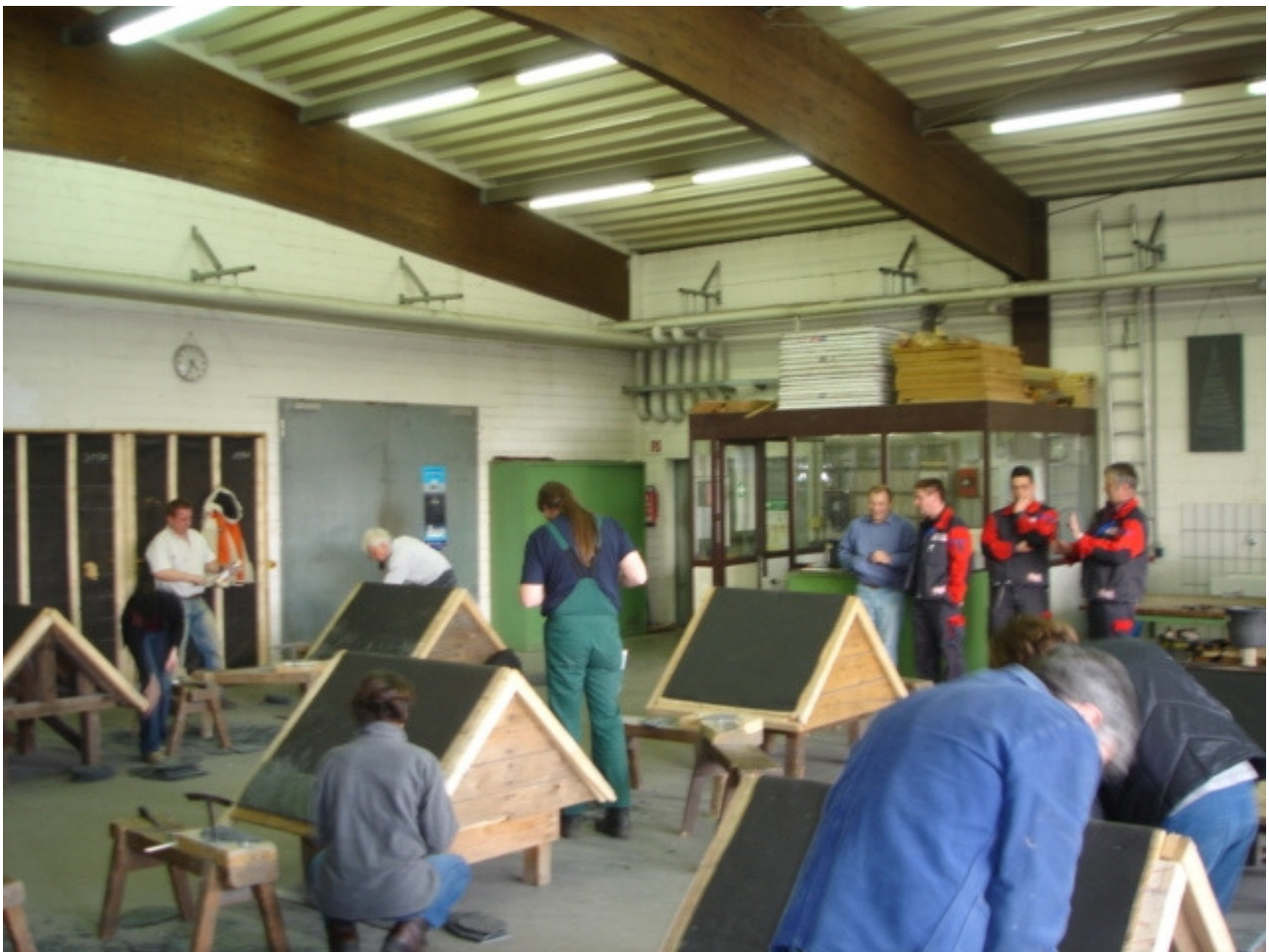
Fachlehrer beim Bearbeiten von Altdeutschen Decksteinen an Steildach-Modellen
