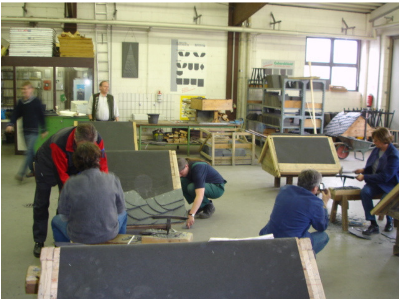
Fachlehrer beim Bearbeiten von Altdeutschen Decksteinen an Steildach-Modellen
